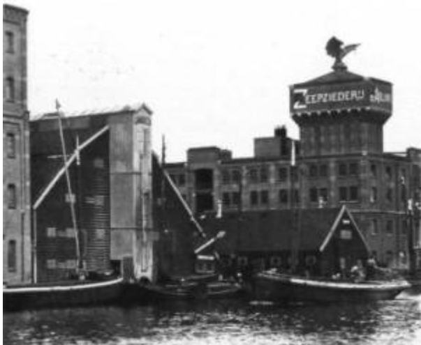
Het fabrieksgebouw van de Adelaar
