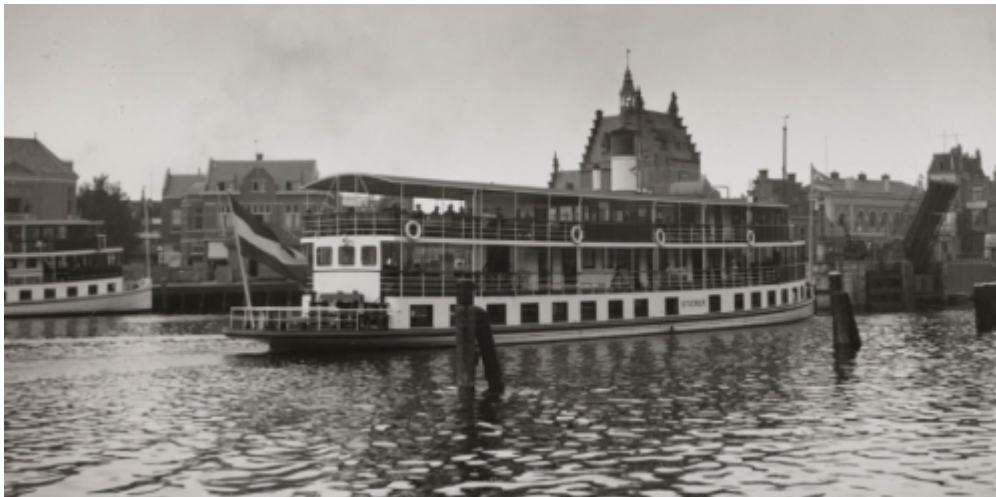
De Stierop van Alkmaar Packet NV voor de Wilhelmina- sluis te Zaandam. Op de achtergrond het vroegere havenkantoor
